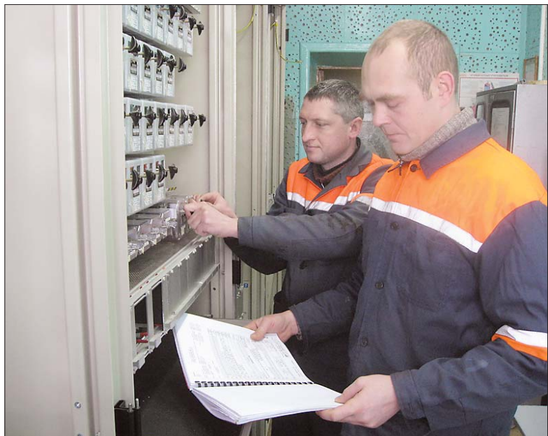
Электромонтер Алексей Хадневич и начальник участка Андрей Шустов проверяют соответствие монтажа схемам
